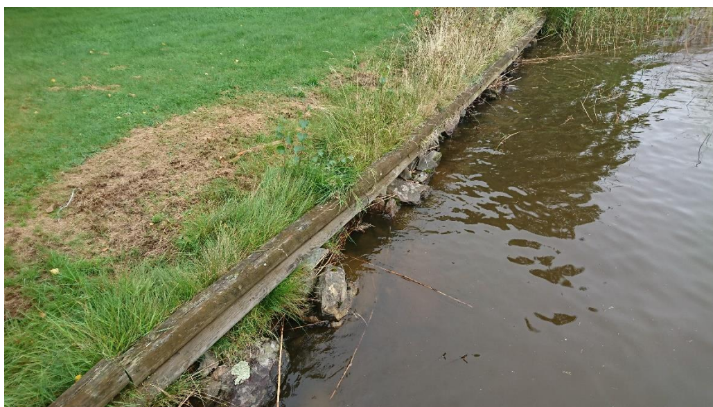
Bild 14; Strandkoning vid Säbytorp 1:113 där utspolning av jord har skett under trästolparna och skapat marksprickor i gräsmattan.
