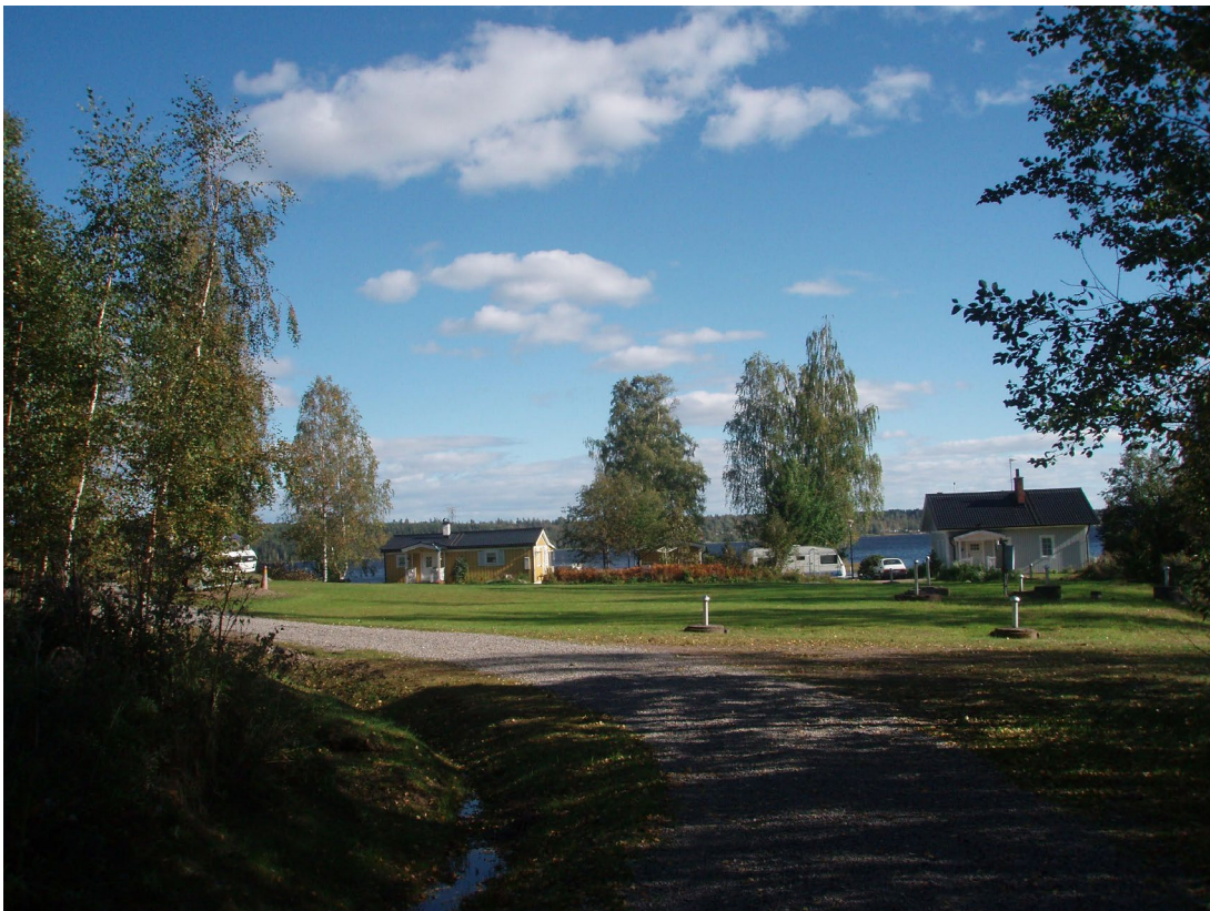
Figur 8: Bild över de södra husen som omfattas av detaljplanen. Husen är i ett våningsplan med stående träpanel.
